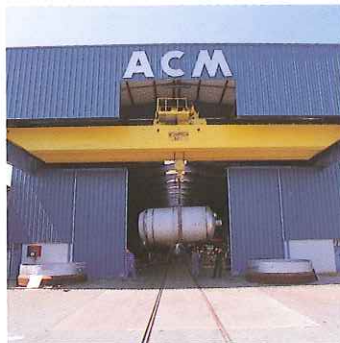
Une maintenance de pièces lourdes (Pont 32 T).
